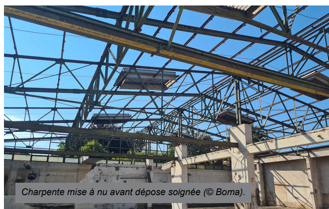
Charpente métallique au moment du diagnostic PEMD (© Boma).
